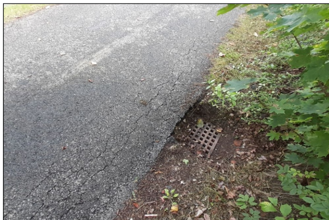
Propustek 10c - staničení 0,296 - pohled zprava
