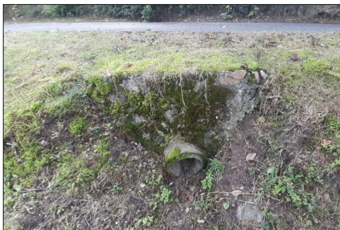
Propustek 10c - staničení 0,296 - pohled zleva
