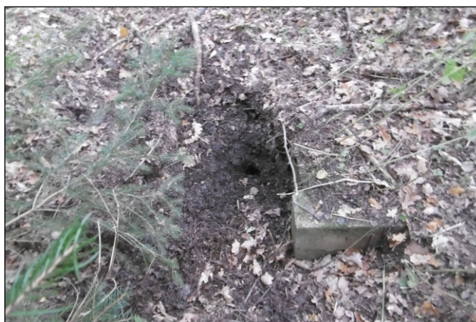
Propustek 14c - staničení 0,109 - pohled zleva
