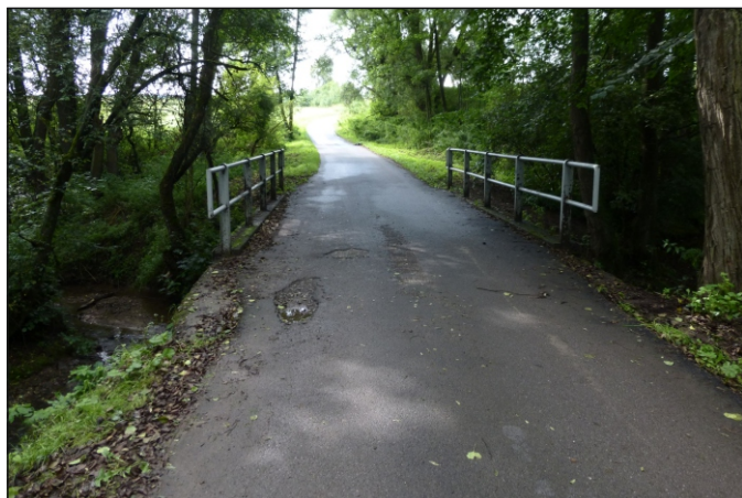
Most 8c-M1 - staničení 0,688 - celkový pohled
