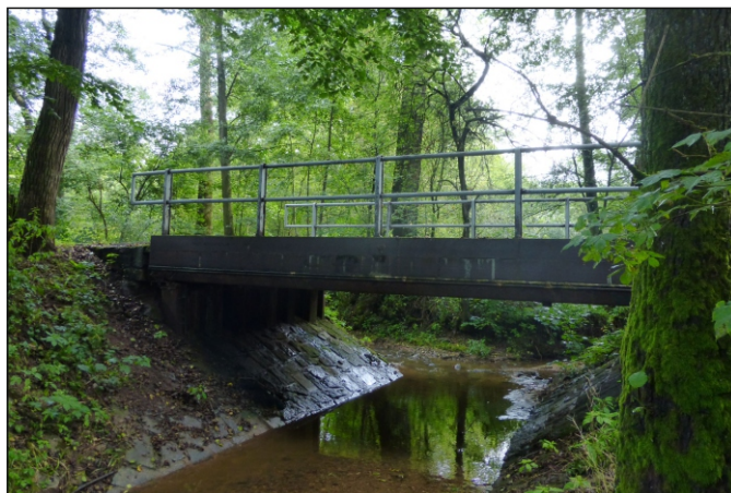
Most 8c-M1 - staničení 0,688 - pohled zleva
