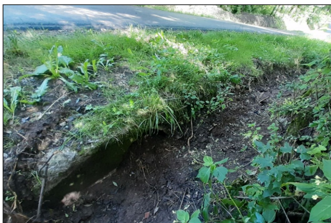
Propustek 5c - staničení 0,759 - pohled zleva
