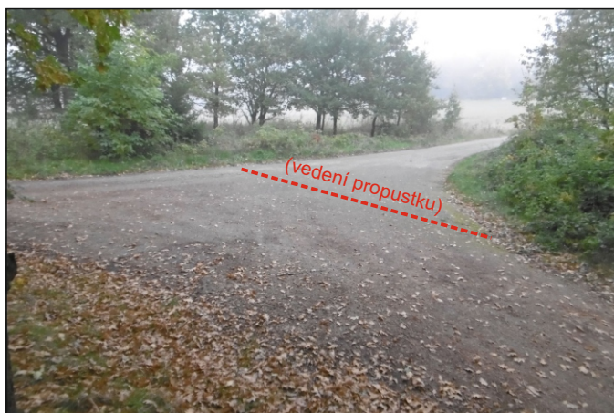
Propustek 14c - staničení 0,109 - celkový pohled
