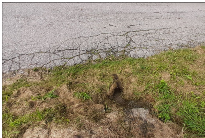
Propustek 12c - staničení 0,018 - pohled zprava
