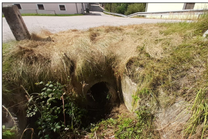
Propustek 8c - staničení 0,002 - pohled zleva
