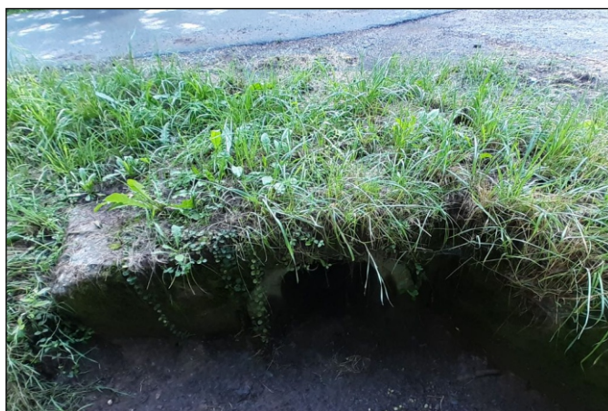
Propustek 5c - staničení 0,759 - pohled zprava
